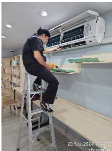
ล้างเครื่องปรับอากาศและแผ่นกรองอากาศพื้นที่ส่วนกลาง
