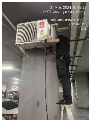
ล้างเครื่องปรับอากาศและแผ่นกรองอากาศพื้นที่ส่วนกลาง
